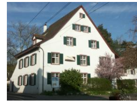
„Fischerhus“ Baselstrasse 24 (4 Begleitplätze)
